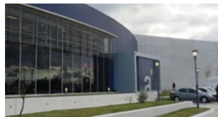
Data center de Antel, en Pando, Uruguay
